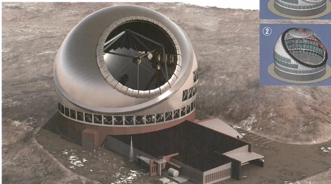
ドームは固定台構造（下の茶色の部分）と、水平方向に回転する基部構造、斜めに回転する帽子型構造、円形のシャッター構造からなります。①は非観測時の状態（②は帽子型構造を透視したようす）。観測時には円形のシャッターが回転して開き（③）、基部構造と帽子型構造の回転により開口部が望遠鏡の向きに合うように制御されます（④）。
